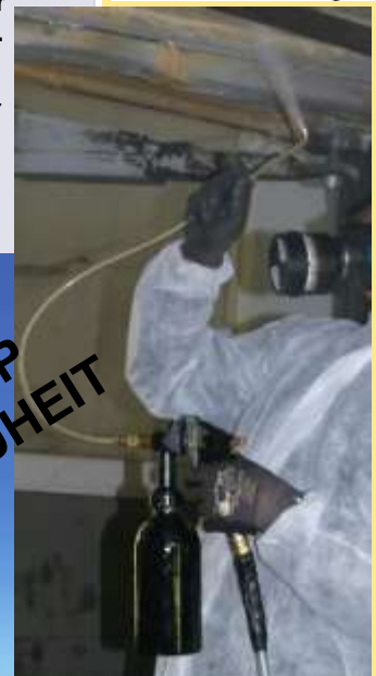
Druckbecherpistole im Einsatz mit TimeMAX Rostschutz
